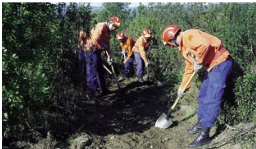
Fig. 33 Faixa de contenção de incêndio construída com material de sapador.
