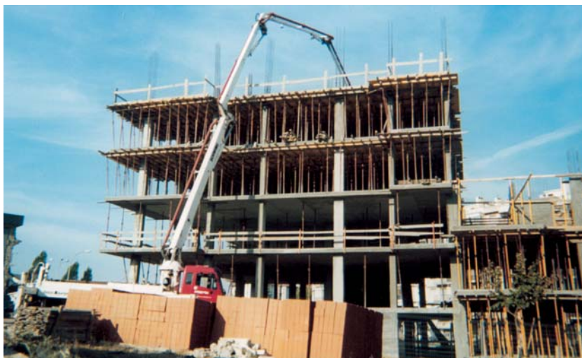
Fig. 5 Exemplo de pilares em betão armado, ainda em construção.
