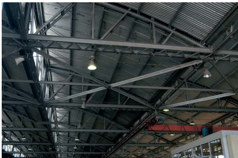
Fig. 6 Estrutura metálica de um armazém.
