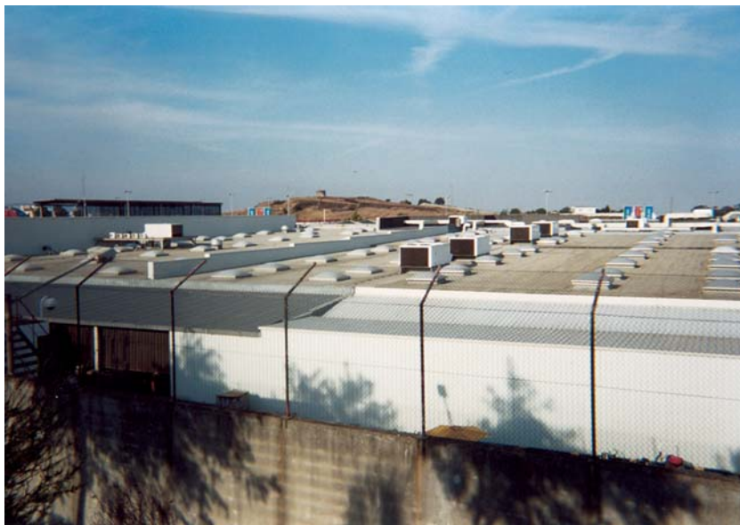
Fig. 10 A carga de uma cobertura em terraço pode aumentar mais que o projectado.
