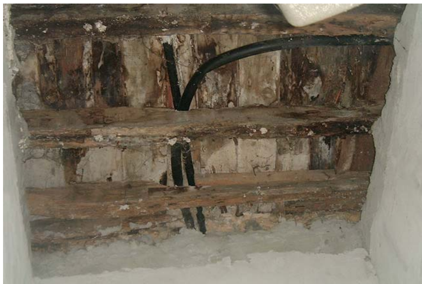
Fig. 42 Apodrecimento da madeira por efeito do ciclo da água.
