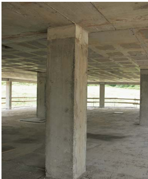
Fig. 18 Laje a descarregar num pilar.
