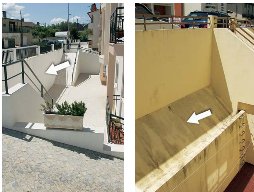
Fig. 19 Muros de suporte em betão armado integrados numa construção.
