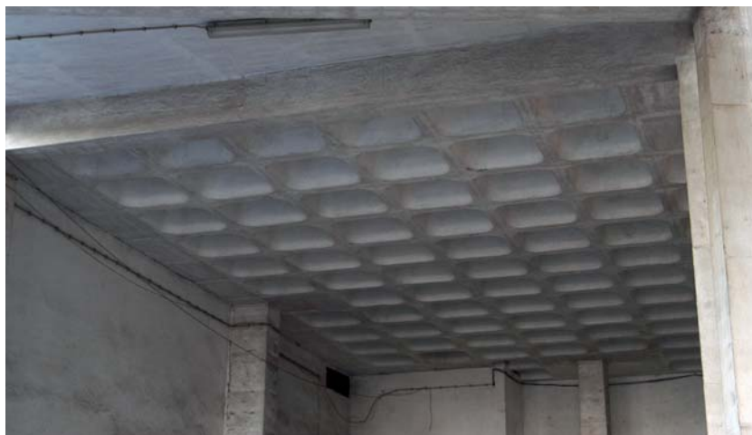
Fig. 13 Exemplo de laje.
