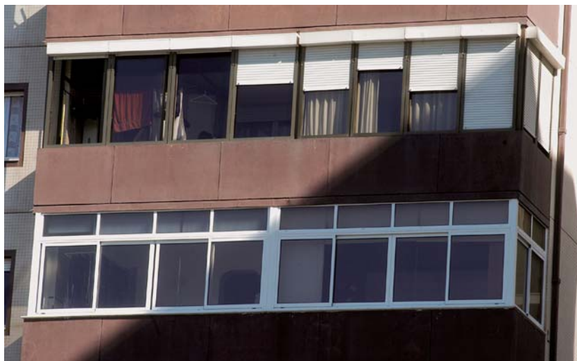
Fig. 15 Varanda fechada com divisória em alumínio.
