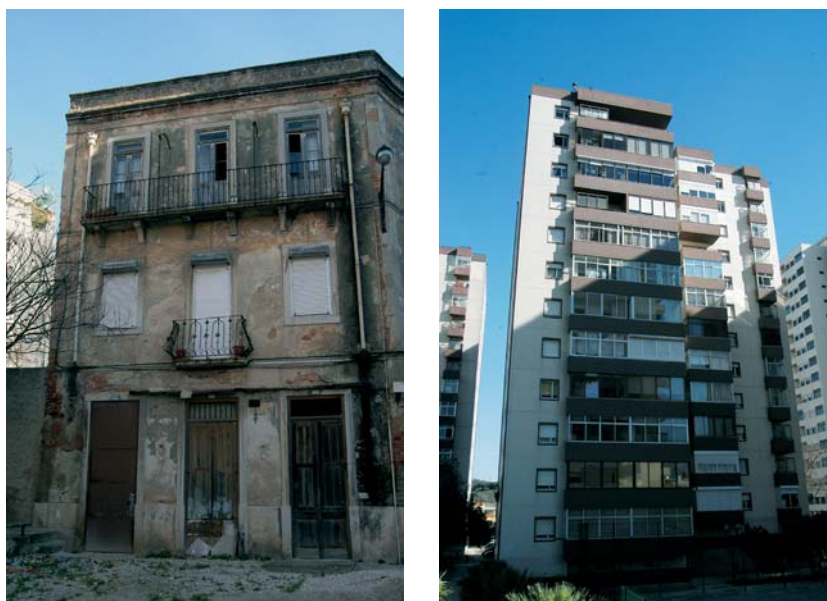
Fig. 40 Numa acção de socorro há que estar atento ao tipo de construção envolvida.
