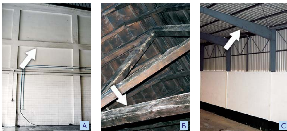
Fig. 16 Exemplos de vigas. A – Em betão armado; B – Em madeira; C – Em perfil metálico (I).
