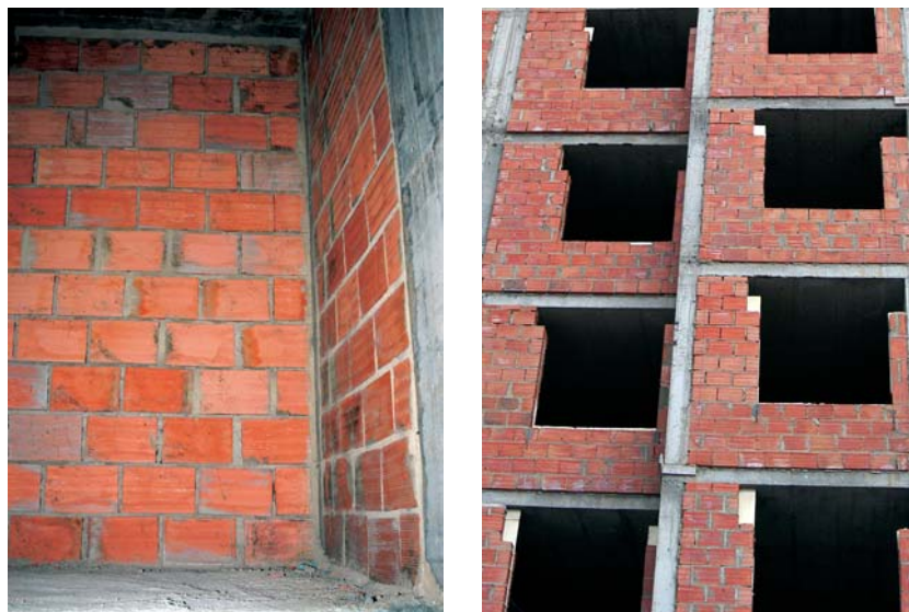
Fig. 23 Paredes interiores e exteriores de um edifício moderno.
