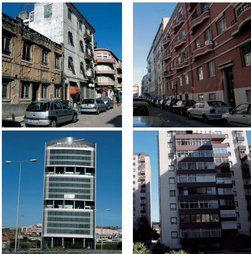
Fig. 24 Fachadas de edifícios.
