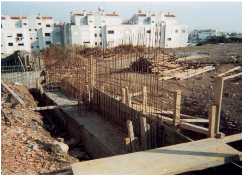
Fig. 28 Muro, ainda em construção, de suporte de terras.
