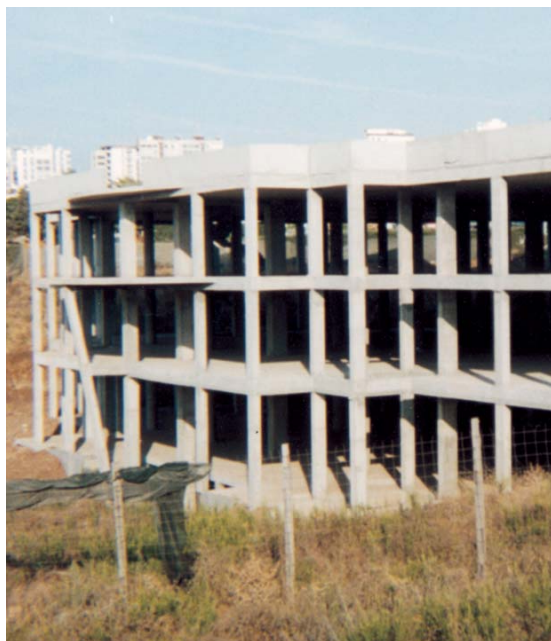
Fig. 12 As lajes, as vigas e os pilares são exemplos de elementos resistentes de um edifício.
