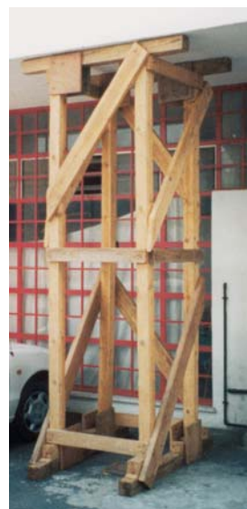
Fig. 46 Por vezes, é necessário escorar as construções para que não ocorram acidentes durante as operações de socorro.
