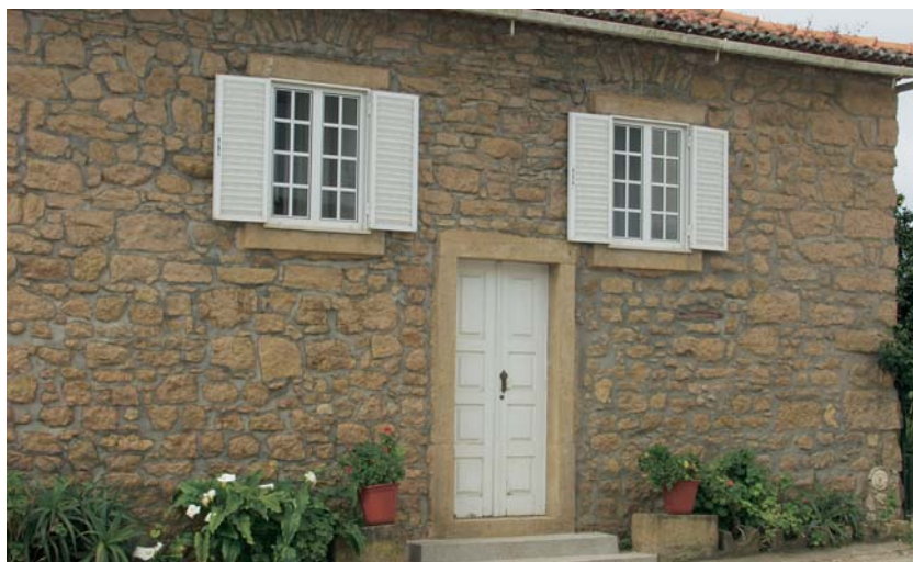
Fig. 4 Parede resistente em pedra natural.
