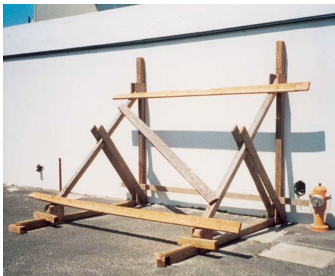
Fig. 46 Por vezes, é necessário escorar as construções para que não ocorram acidentes durante as operações de socorro.
