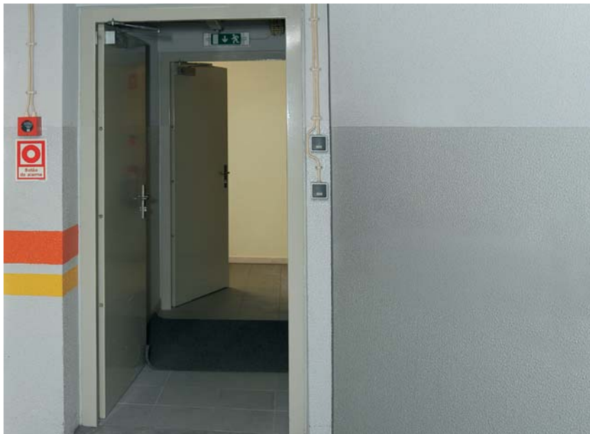
Fig. 34 Parede corta-fogo com porta pára-chamas.
