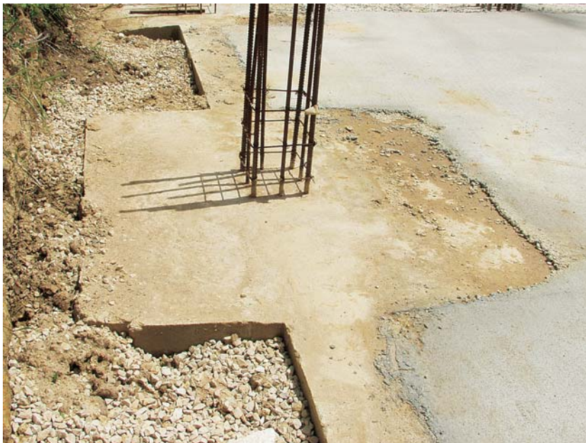
Fig. 20 Exemplo de uma sapata em betão armado.
