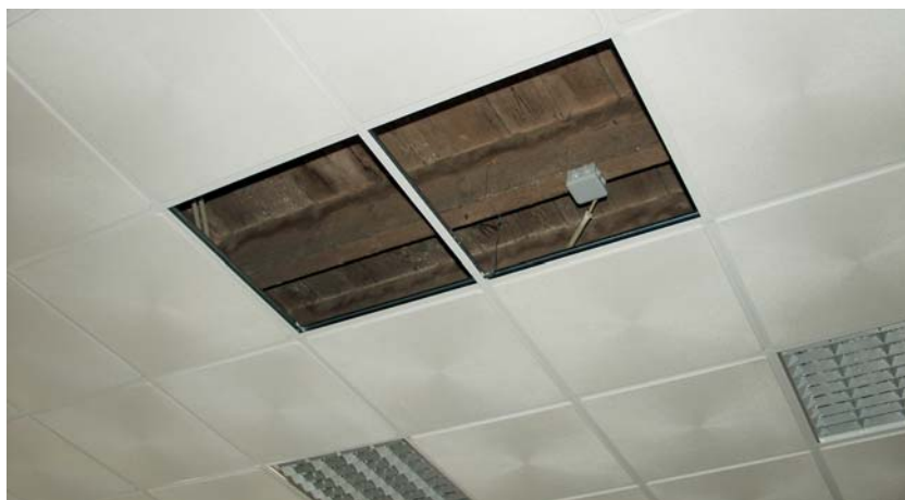
Fig. 32 Tecto falso de gesso.
