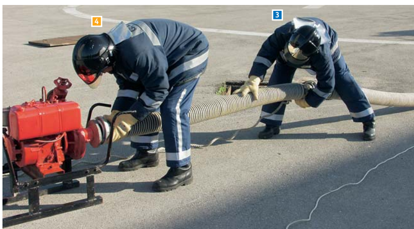
Fig. 93 Ligação dos corpos chupadores à bomba.
