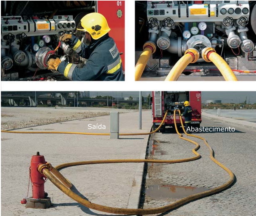
Fig. 98 Abastecimento de uma bomba de incêndio de veículo com conjuntor.
