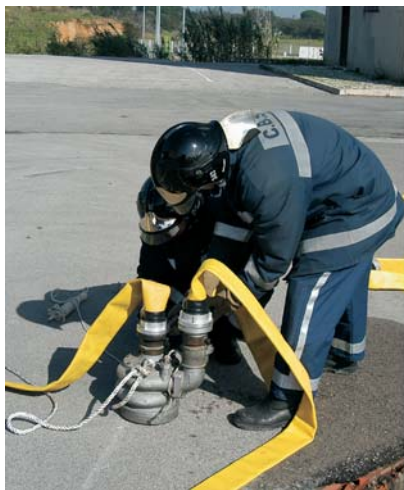
Fig. 111 O n.º 2 faz a ligação dos lanços de mangueira de 70 mm à saída da bomba.
