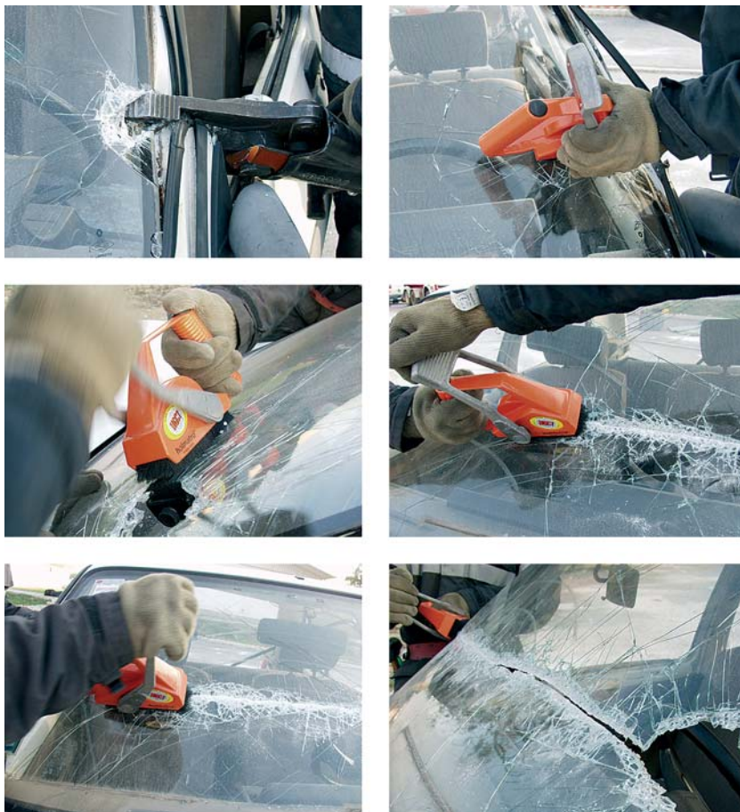
Fig. 49 Remoção de vidro laminado.
