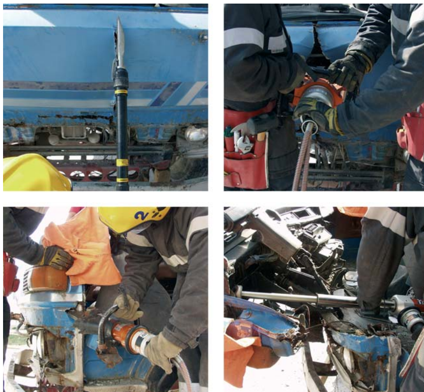
Fig. 118 Corte da barra de reforço e afastamento do tablier.
