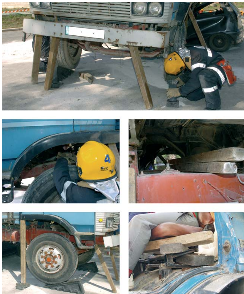
Fig. 113 Estabilização da cabina.
