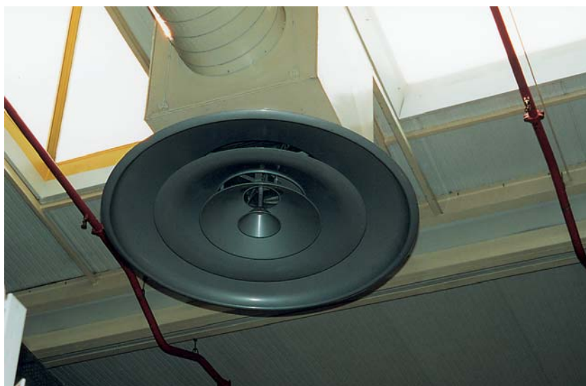
Fig. 9 Captação de ar para extracção mecânica.
