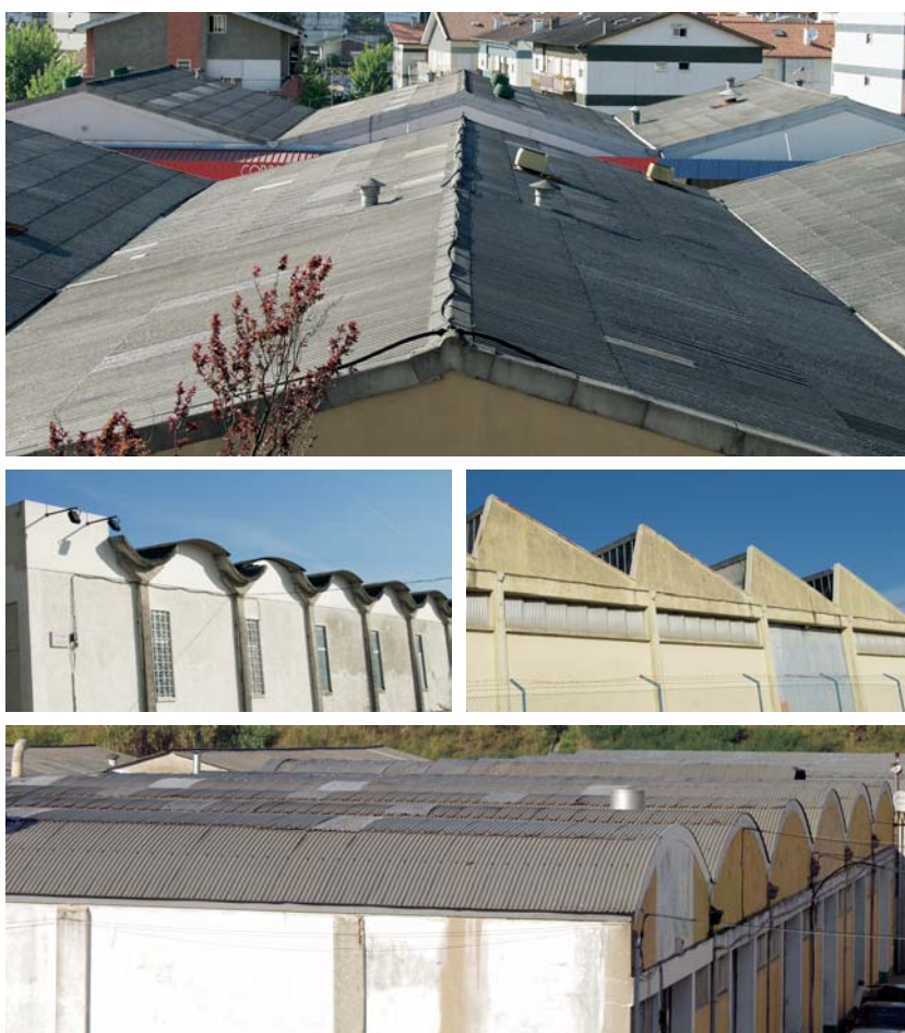
Fig. 11 Alguns tipos mais comuns de coberturas em edifícios industriais.
