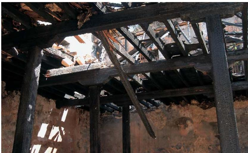
Fig. 43 Estrutura de madeira afectada por um incêndio.
