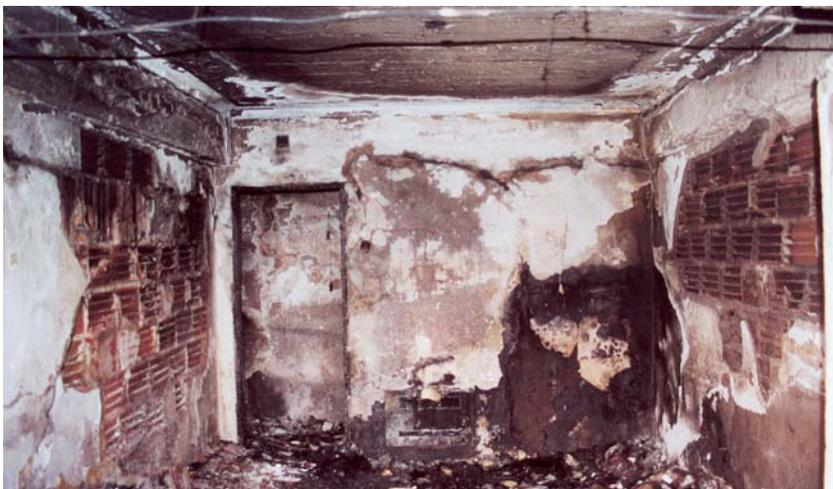
Fig. 44 Elementos de alvenaria afectados por um incêndio.
