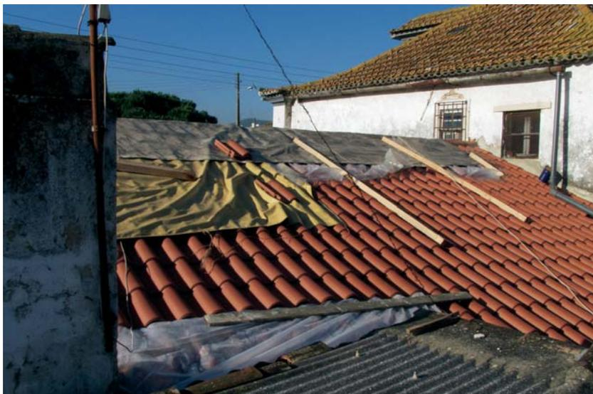
Fig. 36 Protecção de uma cobertura danificada, para evitar a destruição do interior por acção da chuva.
