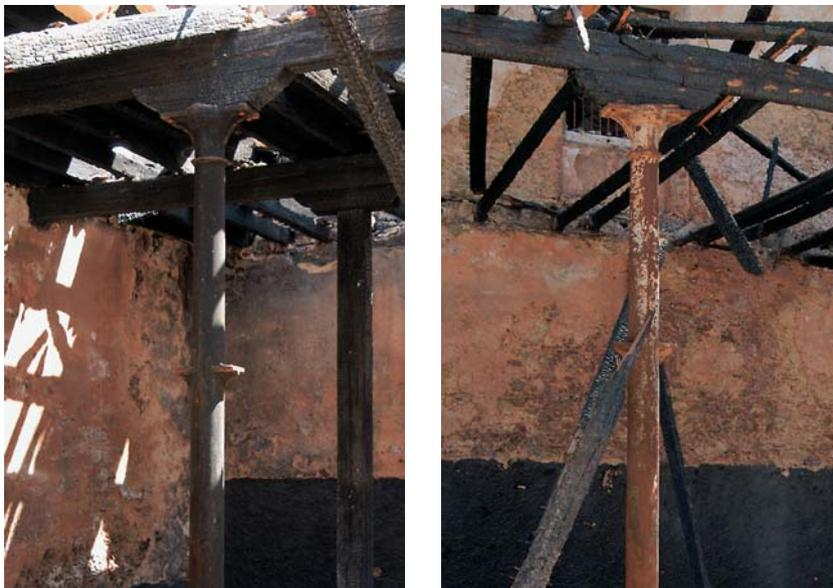
Fig. 42 Pilares metálicos afectados por um incêndio.
