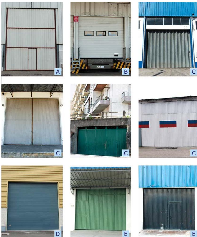
Fig. 33 Exemplos de portões. A – Basculante; B – Correr vertical; C – Correr horizontal; D – Enrolar; E – Correr horizontal com porta de homem.
