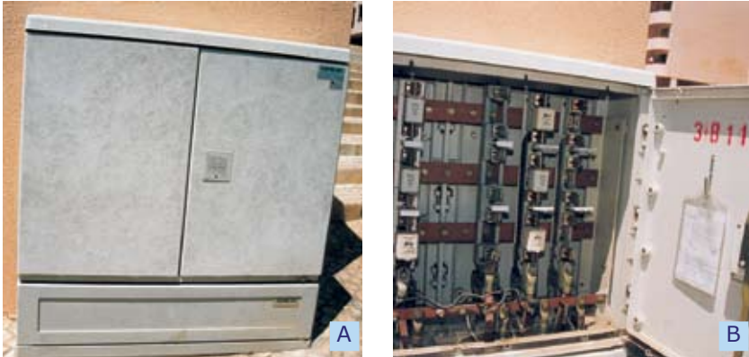
Fig. 24 Armário de distribuição fechado (A) e aberto (B).
