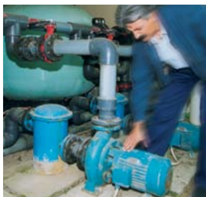
Fig. 34 Contacto indirecto num motor eléctrico.
