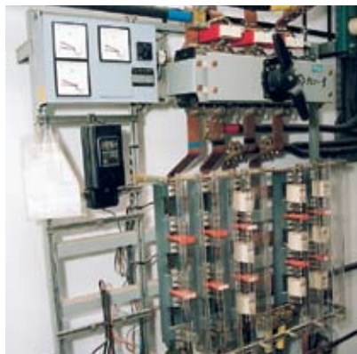
Fig. 22 Quadro geral de baixa tensão.
