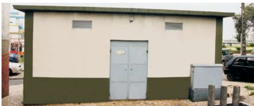
Fig. 20 Posto de transformação do tipo «cabina baixa».
