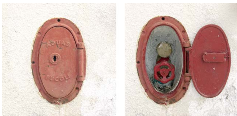
Fig. 11 Boca de incêndio típica.
