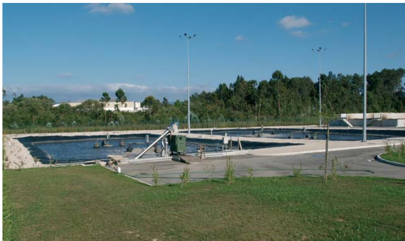
Fig. 38 Estação de Tratamento de Águas Residuais – ETAR.
