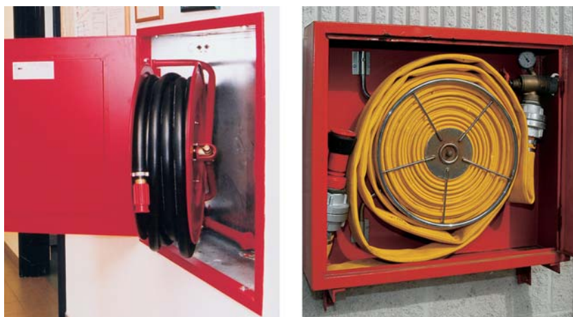
Fig. 32 Exemplos de bocas de incêndio armada.
