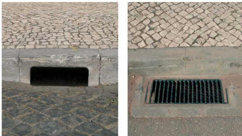
Fig. 40 Exemplo de sarjetas e sumidouros.
